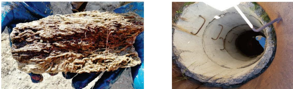
Рисунок 1 – Фрагмент органо - минерального материала и состояние колодца горизонтального трубчатого дренажа
